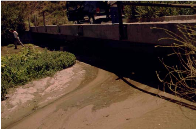
Site 37. Arroyo Las Posas near Somis.
